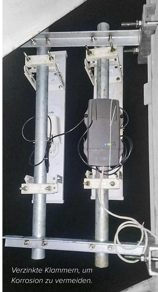
*Verzinkte Klammern, um Korrosion zu vermeiden.*
